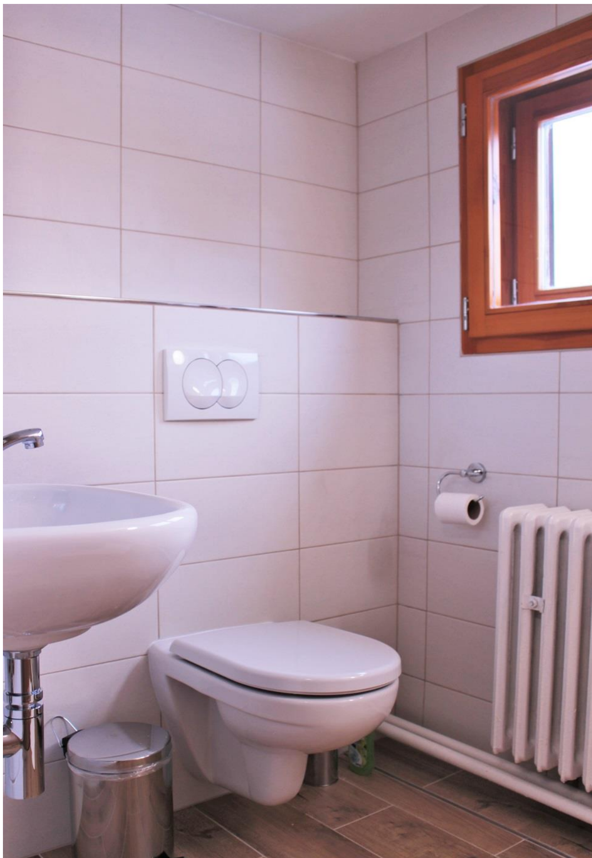
Sociální zařízení přímo přístupné z kuchyně, včetně sprchového koutu
